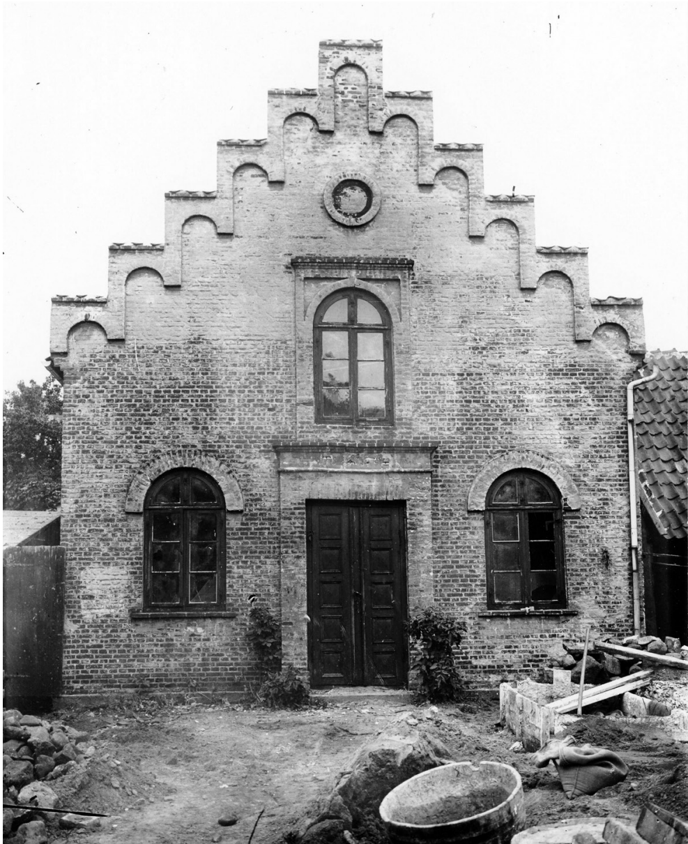
Synagogen i Faaborg under ombygning. Kilde: Faaborg Byhistoriske Arkiv.
