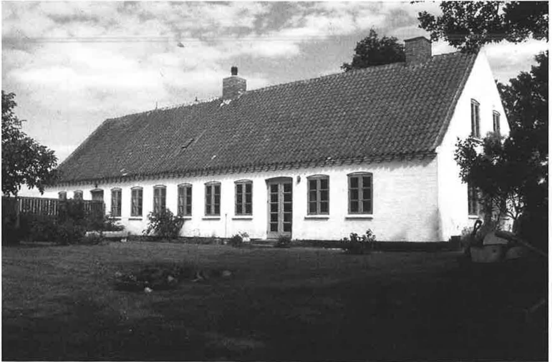
Det nye fattighus i Brandsby. Bag hegnet til venstre er der en døråbning tilsvarende den synlige. På husets modsatte side er der også to døre. De fire døre har været forbundet med to gange, hvorfra der var adgang til et større antal selvstændige beboelser. Der har oprindeligt været en tredje skorsten. (Foto: Langelands Museum).
